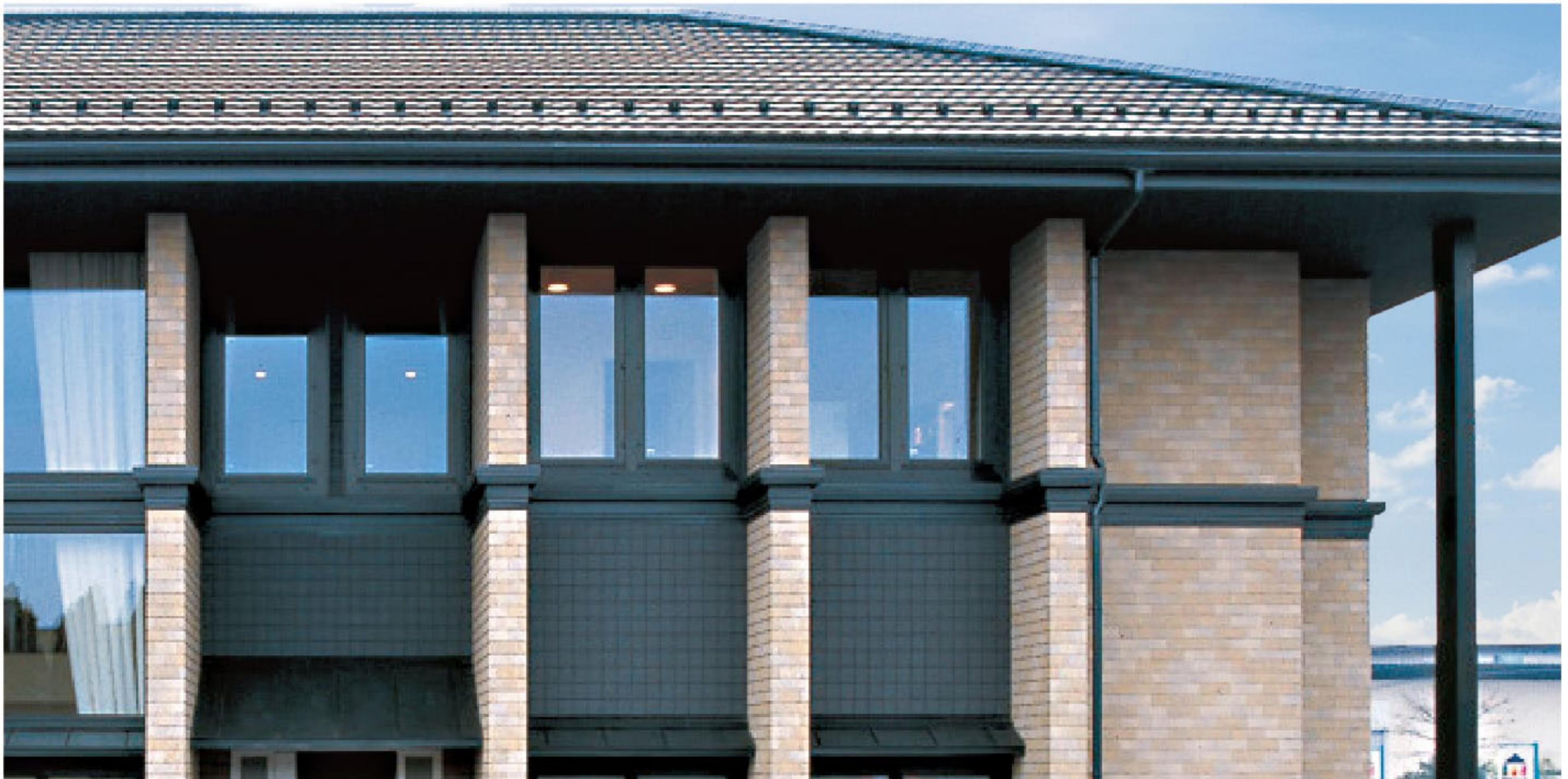
外装に用いられるタイルは主に陶磁器質が多く、タイルそのものは耐水性に優れています。ダメージの多くは目地からの雨水浸入によるものです。ALC(軽量気泡コンクリート)は、軽量でありながら高い断熱性と耐震性を併せ持つ材料として外壁に使われます。表面に塗装を施すことで耐水性を持たせており、塗膜の劣化による不具合が懸念されます。
