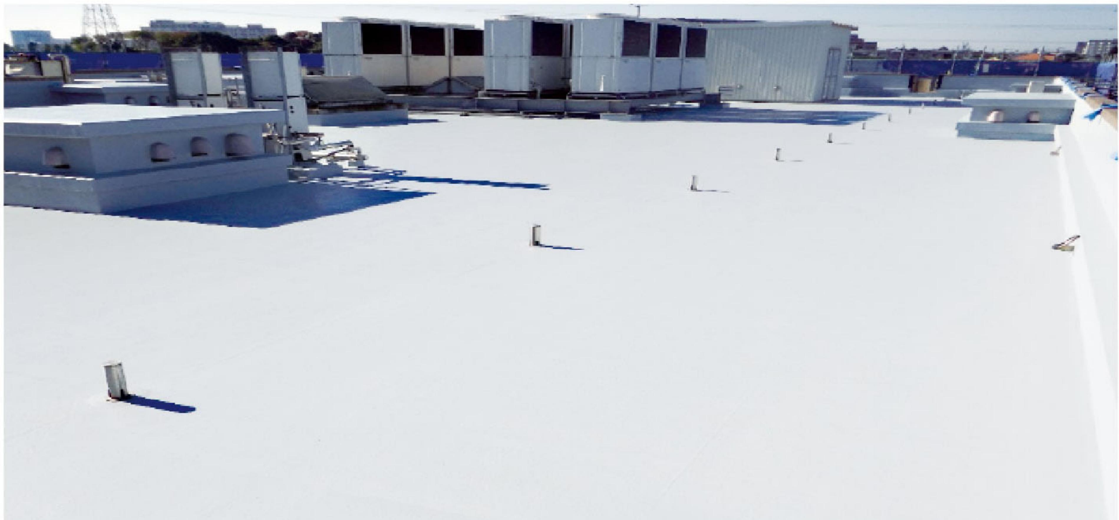
屋上（陸屋根）やベランダ・バルコニーといった部位は、平らに見えますが、排水を考慮して僅かに勾配がつけられています。それでも三角屋根などに比べれば、水が溜まりやすく、漏水や雨漏りなどのリスクも高くなります。そのため、既存状況に合わせた「防水改修工事」が必要です。防水改修工事には防水層を形成する材料や工法の違いによって「シート防水」「ウレタン塗膜防水」「FRP防水」「アスファルト防水」などがあります。
