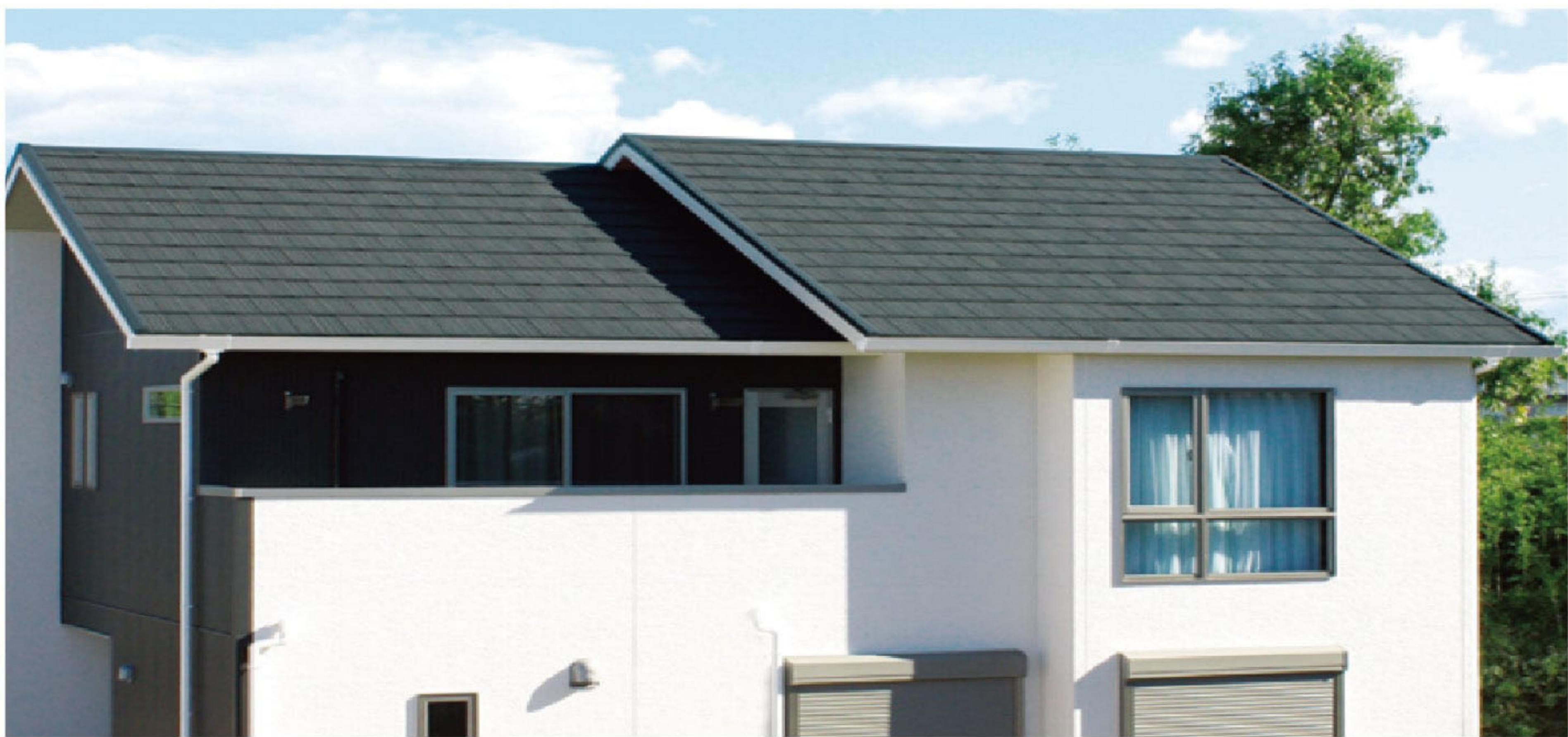
外壁同様、あるいはそれ以上に住空間を守っているのが屋根です。その劣化が建物に及ぼす影響は甚大です。定期的な点検やお手入れのほか、地震や台風といった自然災害の直後など、こまめな点検が不可欠です。また、屋根材の下には、雨水や結露の浸入を防ぐために「ルーフィング（防水紙）」が全面に張られています。屋根材のメンテナンスと合わせてこのルーフィングのケアが重要なポイントです。屋根材の種類は「金属」「スレート」「瓦」といった3種に大きく分類されます。
